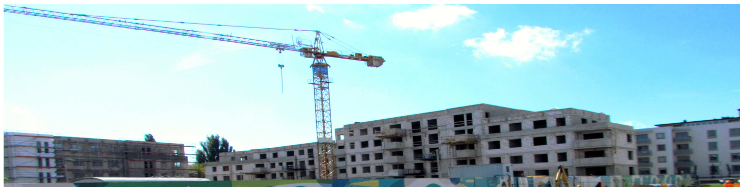
Rysunek 6. Budowa IV etapu inwestycji Barciński Park przez dewelopera SGI
